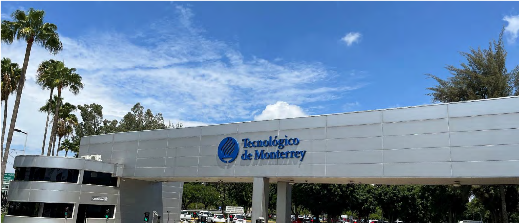
Fig.: Haupteingang der TEC in Zapopan, Guadalajara
